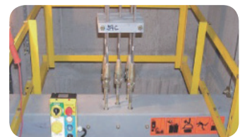
카상부 안전난간대(Car Top Guide Assy)
